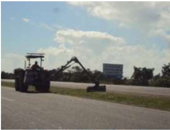
Fotos 03 e 04 – Roçada mecânica e verificação dos elementos de segurança na rodovia
