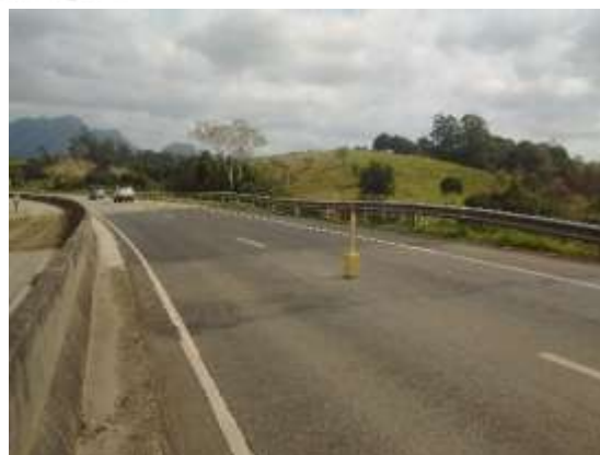
Fotos 11 e 12 – Recuperação dos recalques no pavimento no km 42
