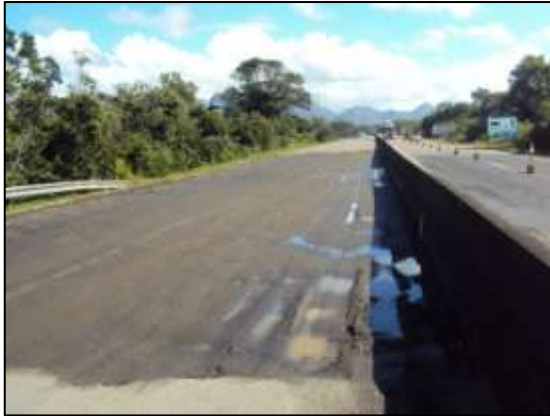
Fotos 01 e 02 – Obra de recuperação do recalque no pavimento no km 42.
