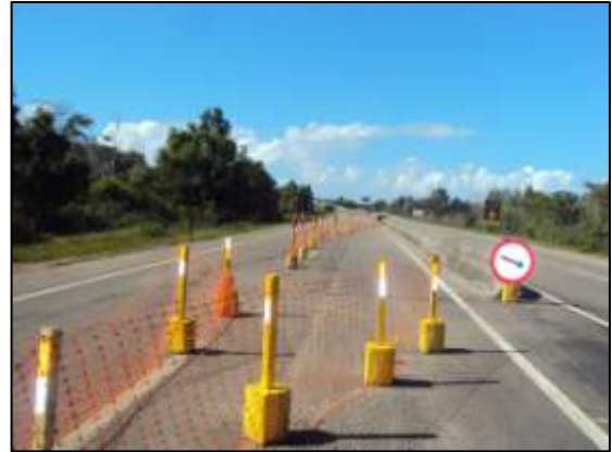
Fotos 01 e 02 – Obra de recuperação do recalque no pavimento no km 42.
