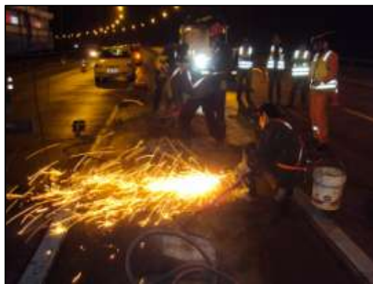
Fotos 03 e 04 – Obras de abertura das medianas na Terceira Ponte AGÊNCIA DE REGULAÇÃO DE SERVIÇOS PÚBLICOS DO ESPÍRITO SANTO
