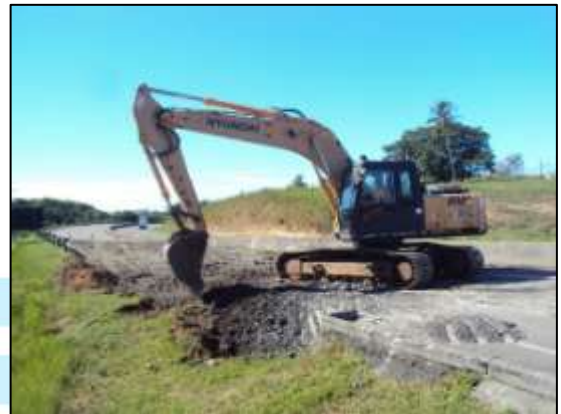
Fotos 09 e 10 – Remoção da capa asfáltica km 42+600
