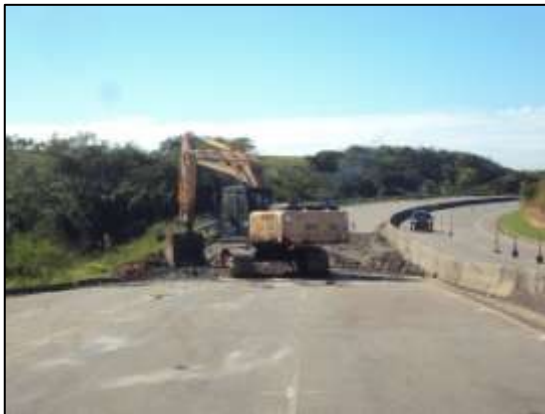
Fotos 09 e 10 – Remoção da capa asfáltica km 42+600
