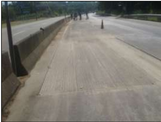
Fotos 13 e 14 – Recuperação do pavimento e fresagem
