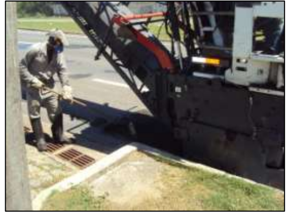
Fotos 07 e 08 – Reparos localizados na superfície asfáltica
