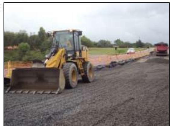
Fotos 11 e 12 – Aplicação de manta geotêxtil e espalhamento de brita no km 42+600
