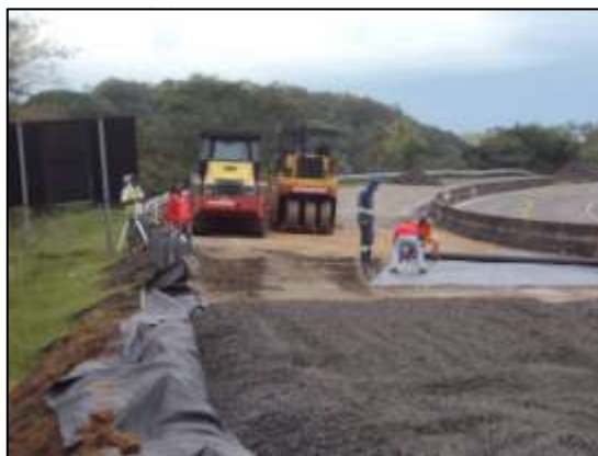
Fotos 11 e 12 – Aplicação de manta geotêxtil e espalhamento de brita no km 42+600
