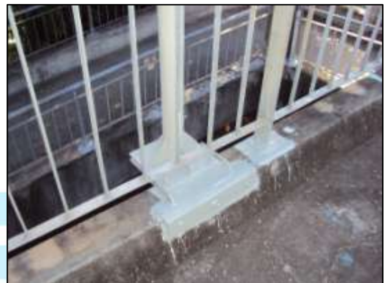
Fotos 15 e 16 – Recuperação do concreto e pintura de base metálica em passarela
