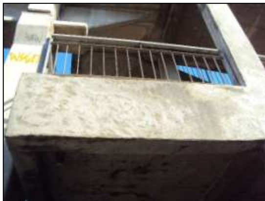
Fotos 15 e 16 – Recuperação do concreto e pintura de base metálica em passarela
