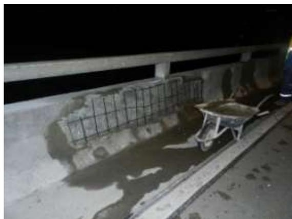
**Foto 26** – Equipe da RODOSOL executando limpeza e retirada de oxidação de armaduras para aplicação de novo recobrimento.
