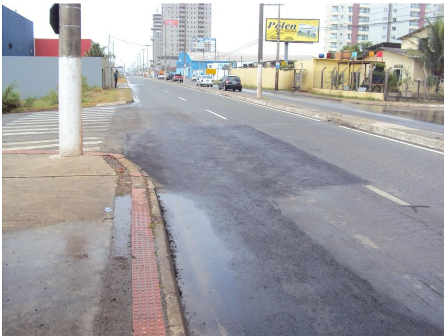
Pavimento Recuperado - Km 9+000 – Norte
