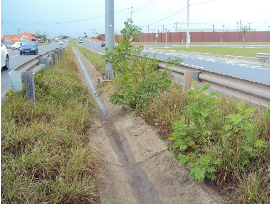
Vegetação alta junto às defensas metálicas no canteiro central – km 21+300
