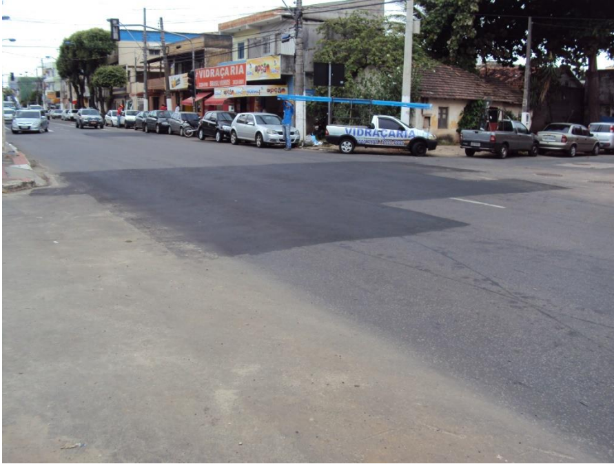
Pavimento Recuperado - Av. Luciano das Neves, próximo ao Colégio UP
