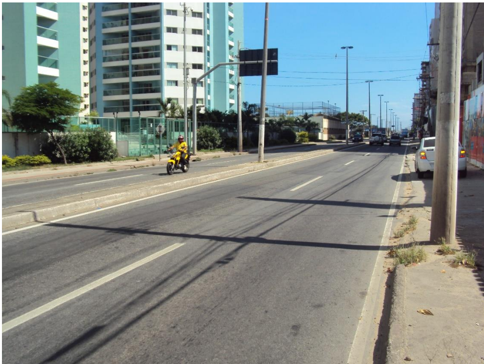
Condições gerais da rodovia – Trecho urbano – Km 8 + 600 - Sul
