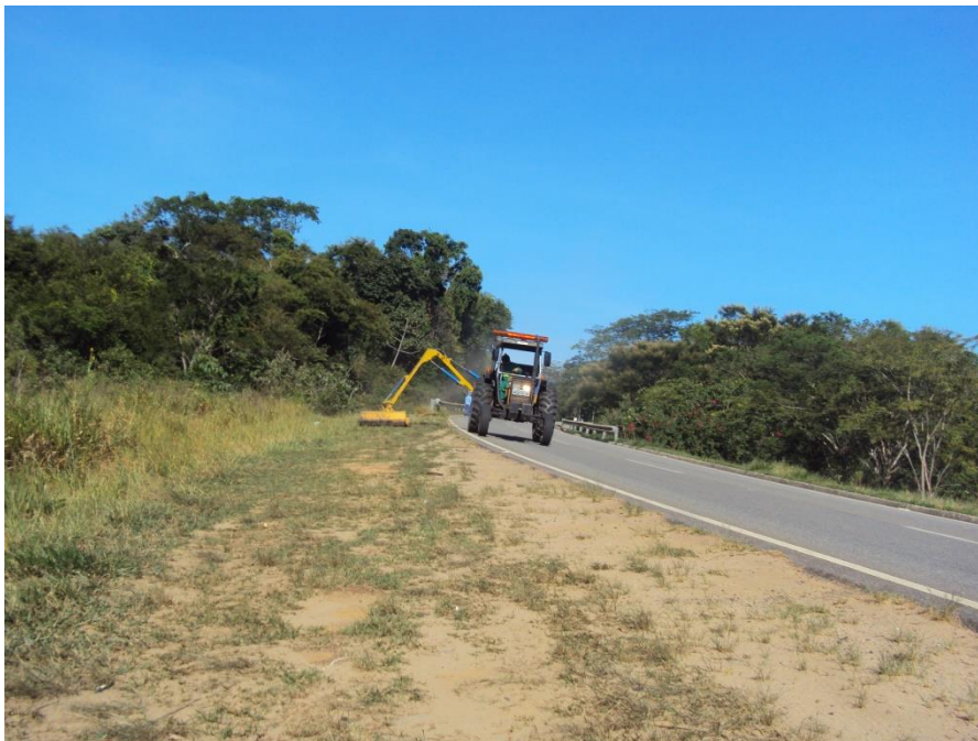
Roçada Mecânica em execução – Km 50 - Sul
