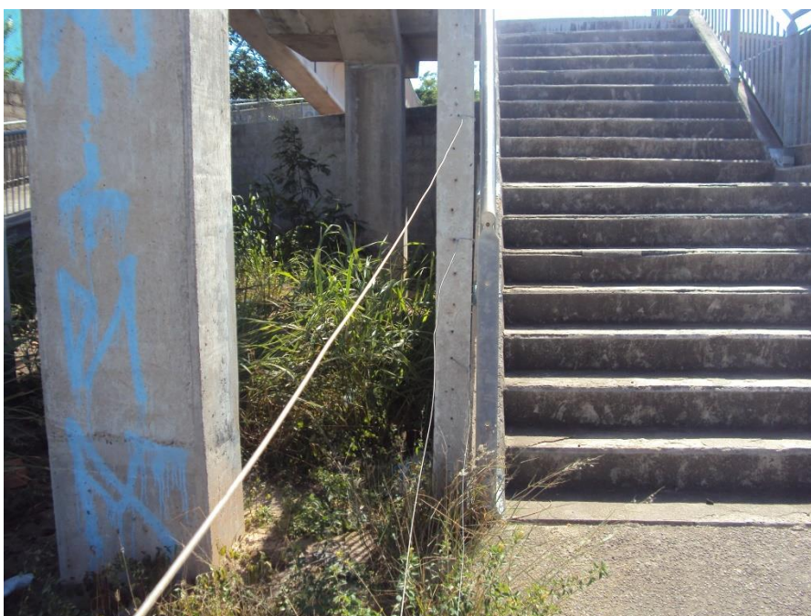
Vegetação alta – Passarela do Km 25
