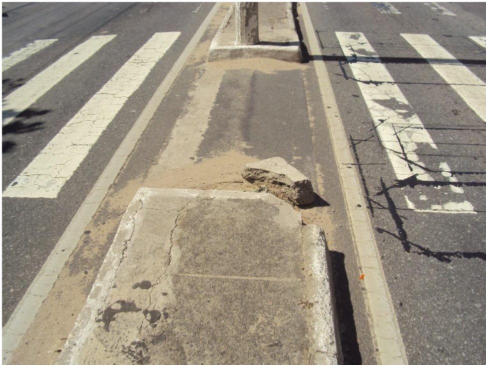
Canteiro Central Avariado – Interseção do Hotel Faraó
