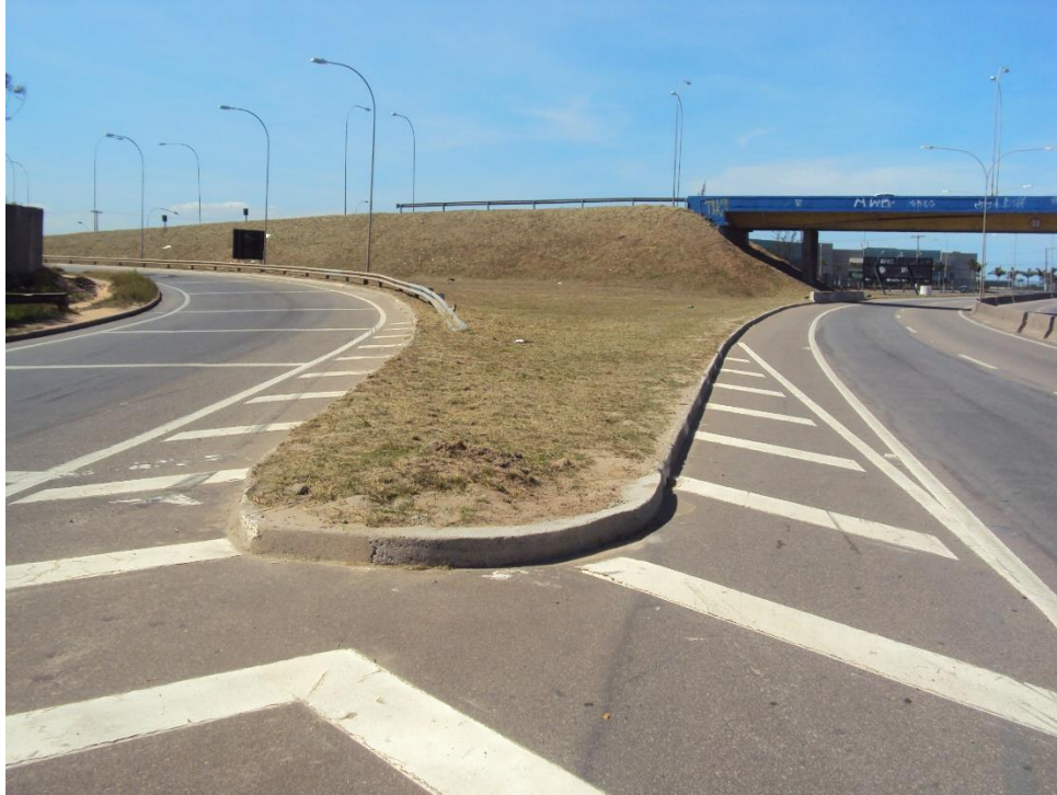
Condições gerais da rodovia e canteiro - Viaduto da Darly Santos
