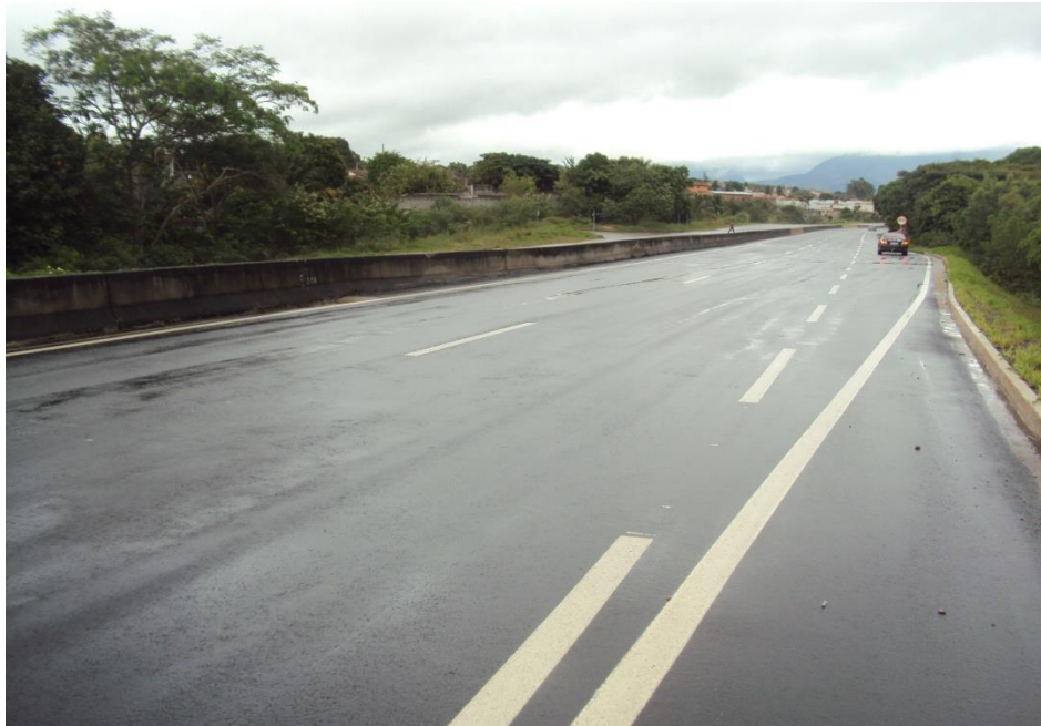
Condições gerais da rodovia no km 43
