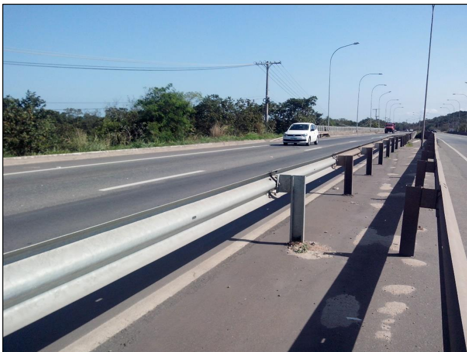
Defensas Metálicas próximas a ponte sobre o Rio Jucu
