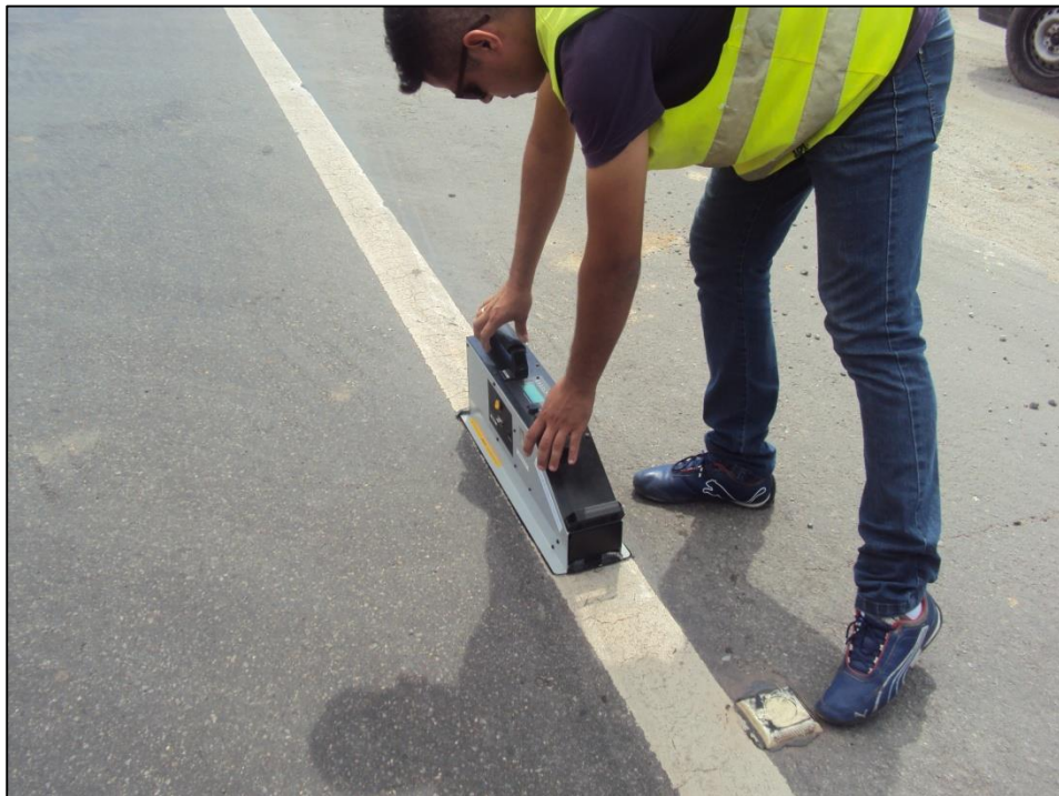
Leitura da Retrorrefletividade da Sinalização Horizontal – Funcionário da LENCO
