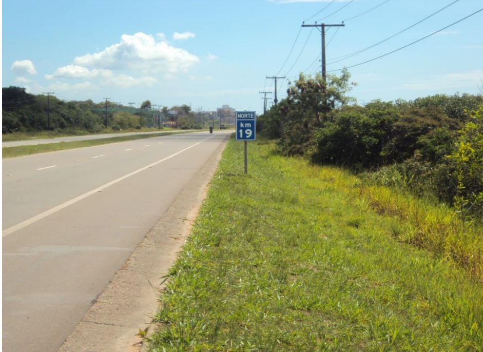
Roçada realizada no Km 19 - Norte
