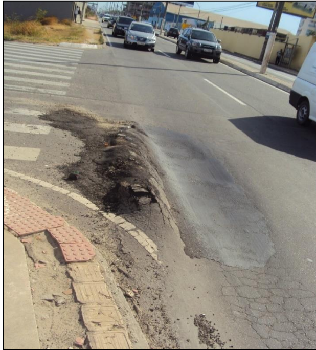
Afundamento Crítico no Pavimento do Km 09 – Pista Norte
