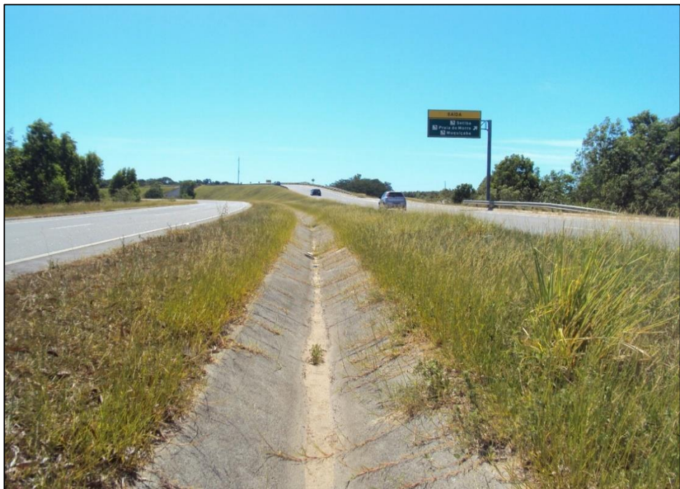
Sistema de Drenagem Próximo do Trevo de Setiba – Canteiro Central
