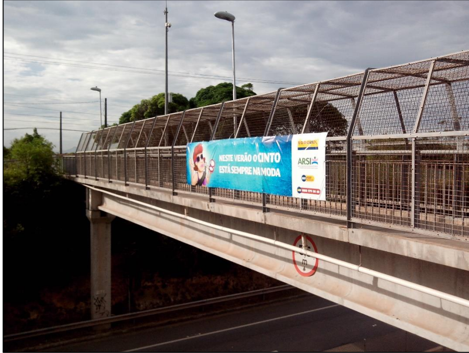
Passarela Recuperada no Morro da Lagoa
