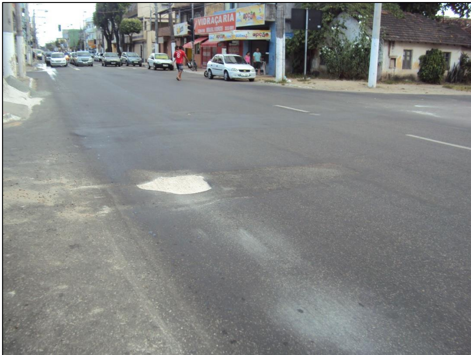
Panela no Pavimento da Av. Luciano das Neves – Pista Sul
