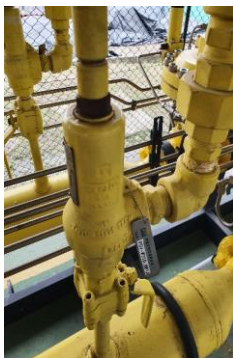
Figura 2 - Válvula PSV ERP Jardim Limoeiro
