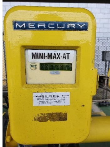
Figura 8 - Computador de vazão ERP Jardim Limoeiro/Tramos.
