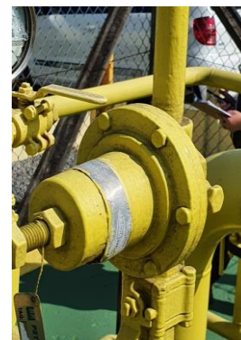
Figura 4 - Válvula PSV ERP Apart Hospital
