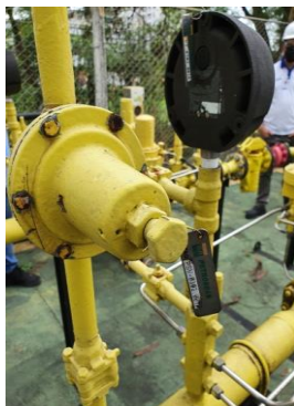
Figura 3 - Válvula PSV ERP Cesan
