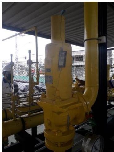
Figura 5 - Válvula PSV ERP Jardim Limoeiro
