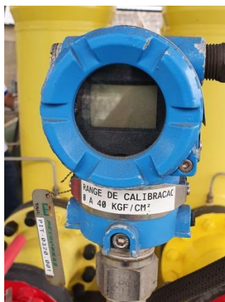
Figura 6 - PIT ERP Jardim Limoeiro/Entrada.
