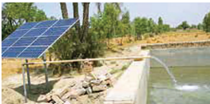
FIGURA 7.7 Exemplos de formas de uso da energia solar na irrigação (sistema isolado, off-grid)
