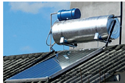
FIGURAS 2.4 Principais formas de aplicações da energia solar térmica nas edificações residenciais
