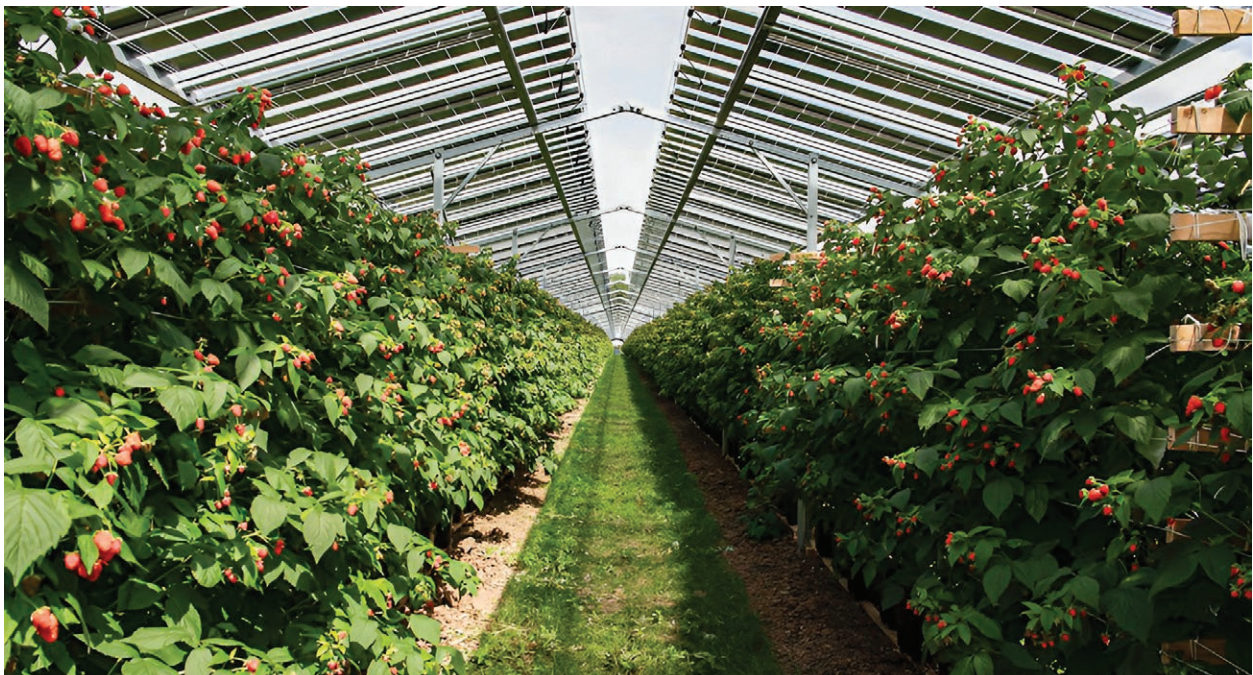
FIGURA 10.18 Sistema agrivoltaico instalado em substituição a estufa do morangueiro 1
