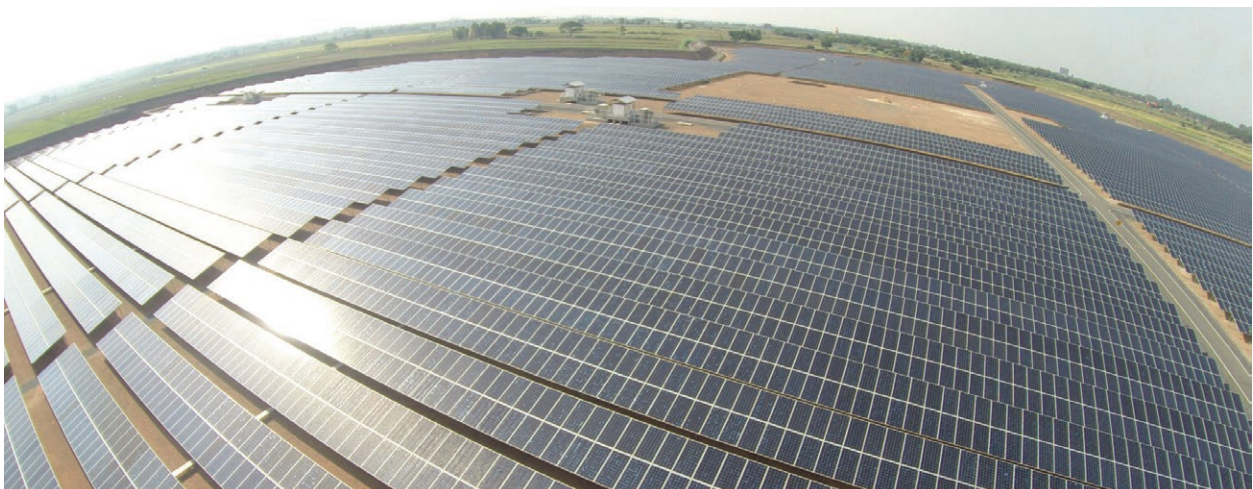
FIGURA 10.8 Usina Solar Nova Olinda, Ribeira do Piauí, PI, 292 MWp
