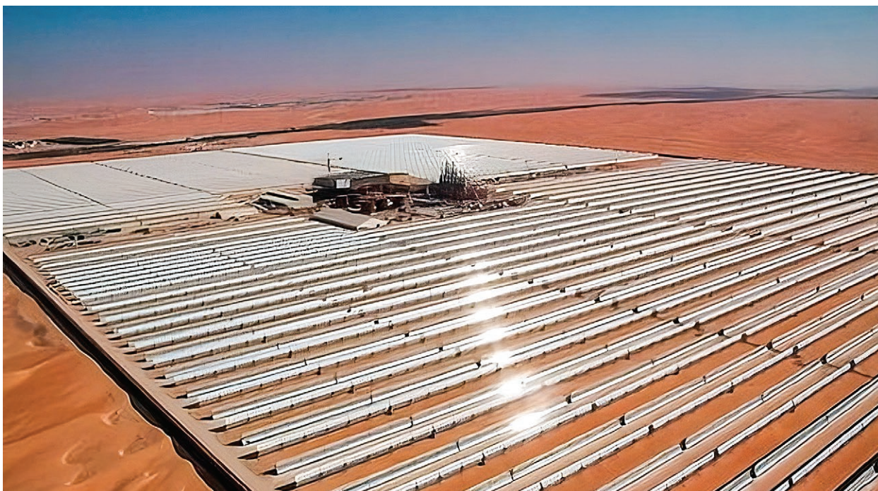
FIGURA 10.1 Usina por Concentração Solar (CSP) com coletores cilindro-parabólicos, Shams 1
