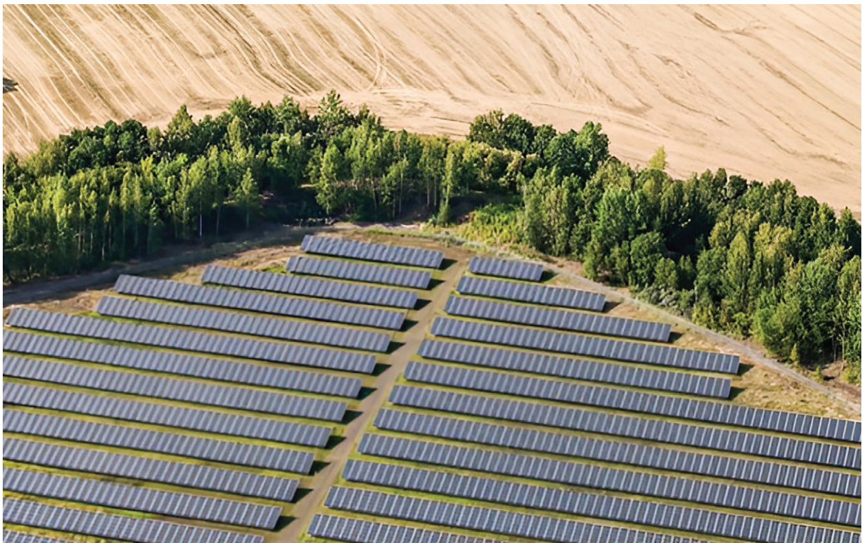
FIGURA 10.4 Parque Solar Caucharí, província de Jujuy, Argentina
