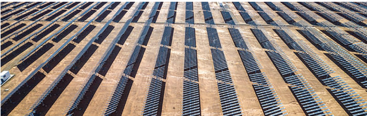
FIGURA 10.6 Usina Solar Fotovoltaica São Gonçalo do Gurguéia, Piauí
