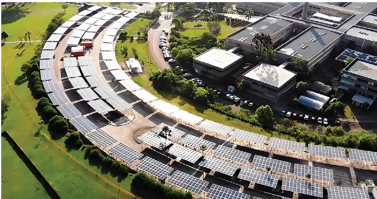
FIGURA 10.21 Usina solar fotovoltaica no estacionamento da UFPR, Curitiba, PR
