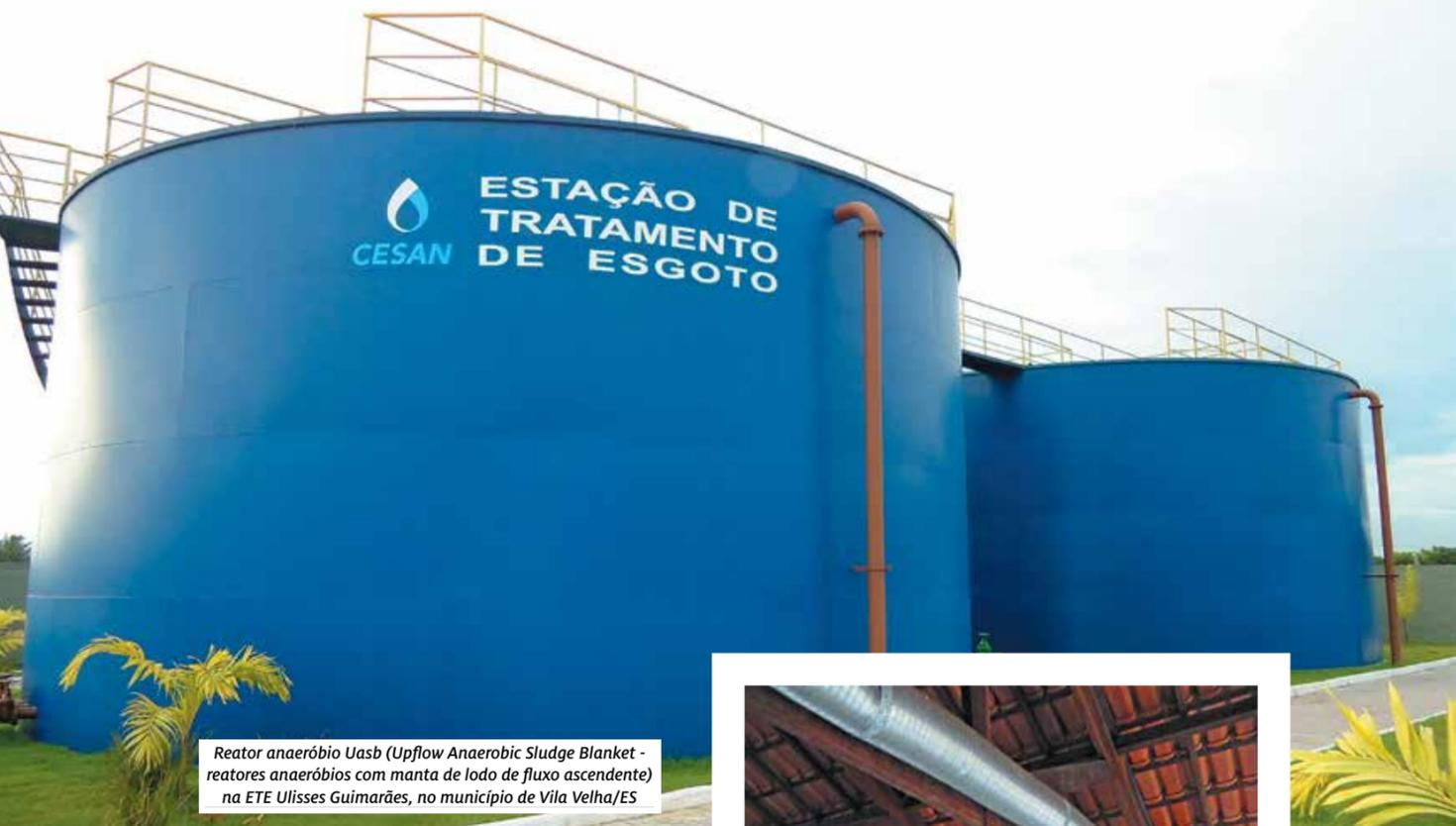
Reator anaeróbio Uasb (Upflow Anaerobic Sludge Blanket - reatores anaeróbios com manta de lodo de fluxo ascendente) na ETE Ulisses Guimarães, no município de Vila Velha/ES
