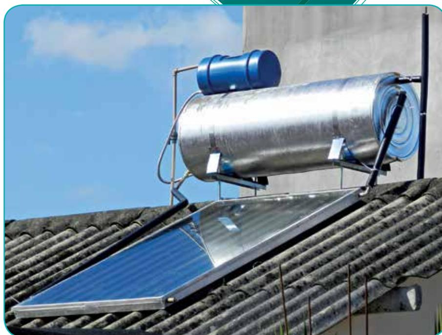
Quanto ao funcionamento, utiliza-se o sistema de termosifão, em que a água aquecida pelo coletor, menos densa (indicada em vermelho), retorna para o reservatório e a mais fria, mais densa (indicada em azul), desce para o coletor, fechando assim o ciclo (consultar o capítulo 4).
