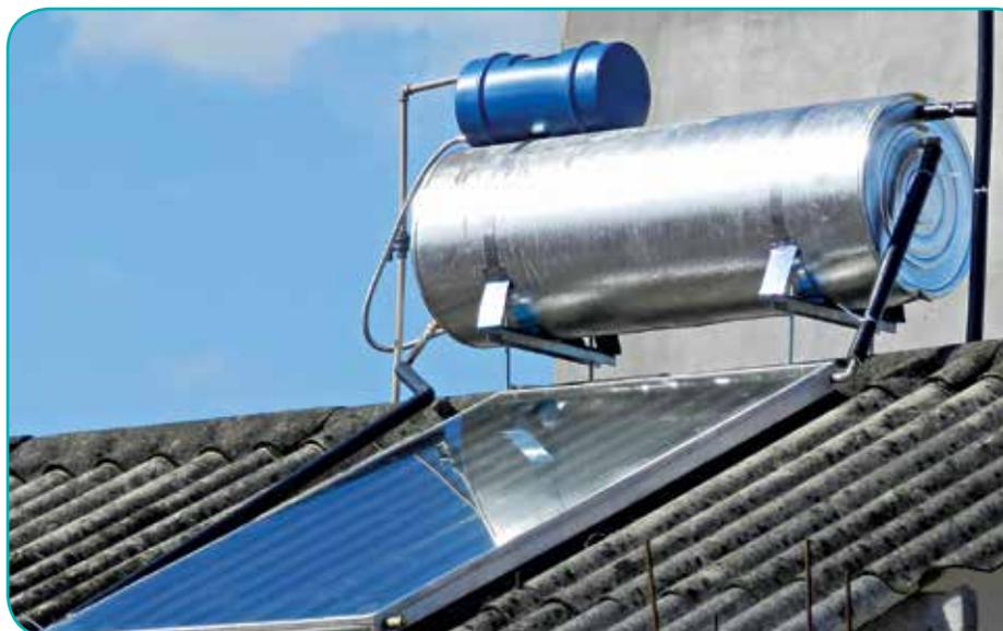
**Aquecedor solar (reservatório e placa)**
