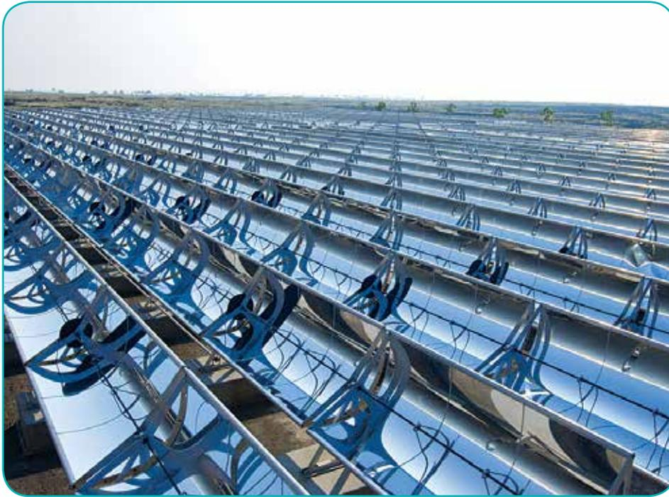
*Esquema e exemplo de usina de concentradores cilíndricos*
