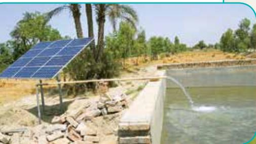
**Aproveitamento da energia solar na irrigação (sistema isolado)**
