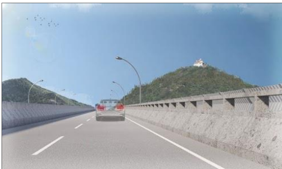
FIGURA 6 – Visão sob a ponte com a barreira instalada.
