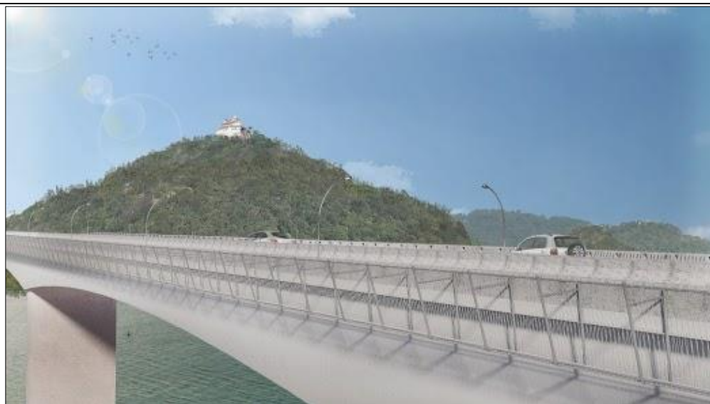
FIGURA 9 – Visão lateral com barreira instalada.
