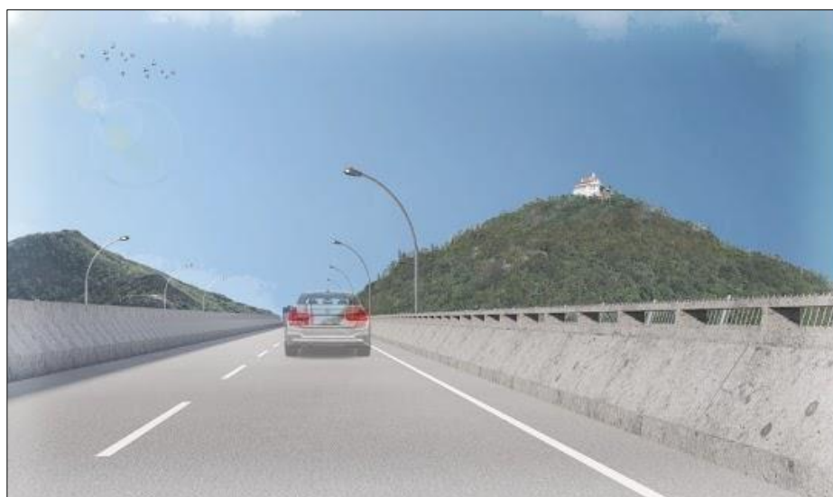
FIGURA 10 – Visão sob a ponte com a barreira instalada.
