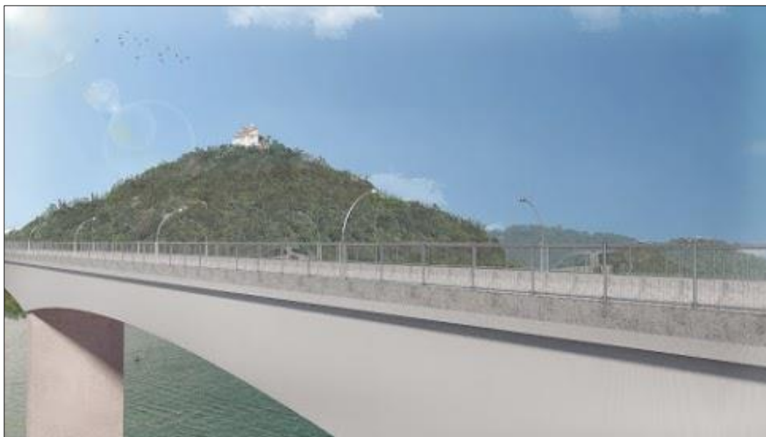
FIGURA 2 – Visão lateral com barreira instalada.
