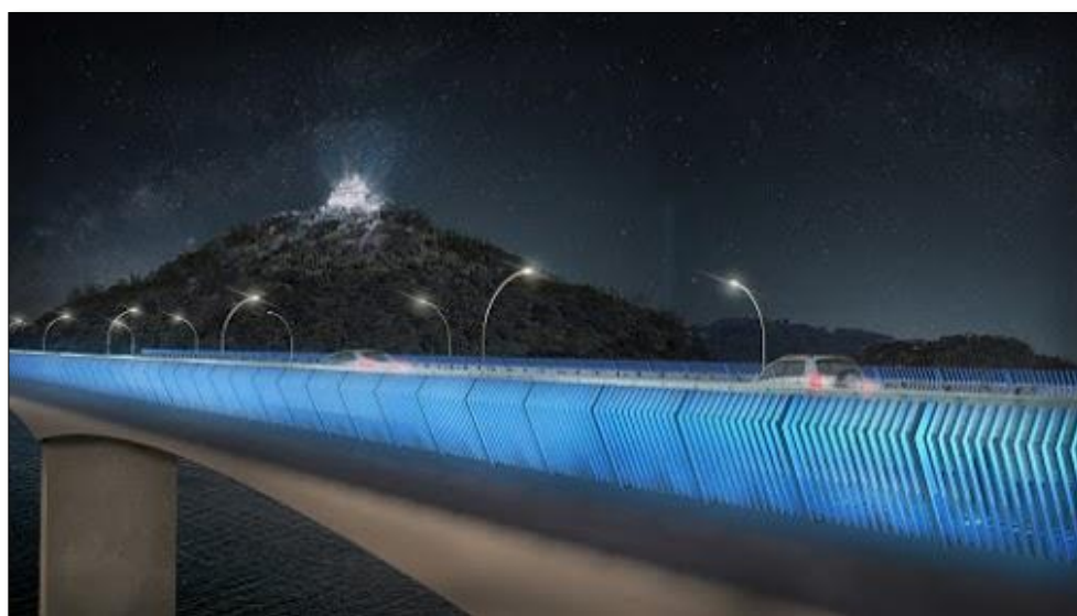
FIGURA 7- Visão lateral da ponte com barreira instalada e iluminada.
