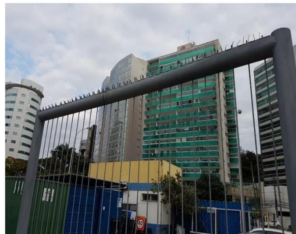
Fotos 5 e 6: Cabos rígidos verticais com pontas perfurantes na estrutura de sustentação horizontal
