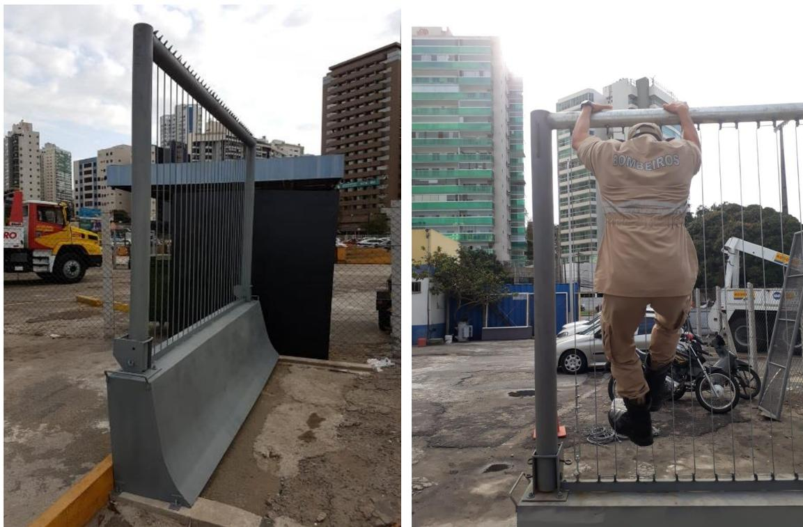
Foto 7: Cabos rígidos verticais com pontas perfurantes na estrutura de sustentação horizontal
